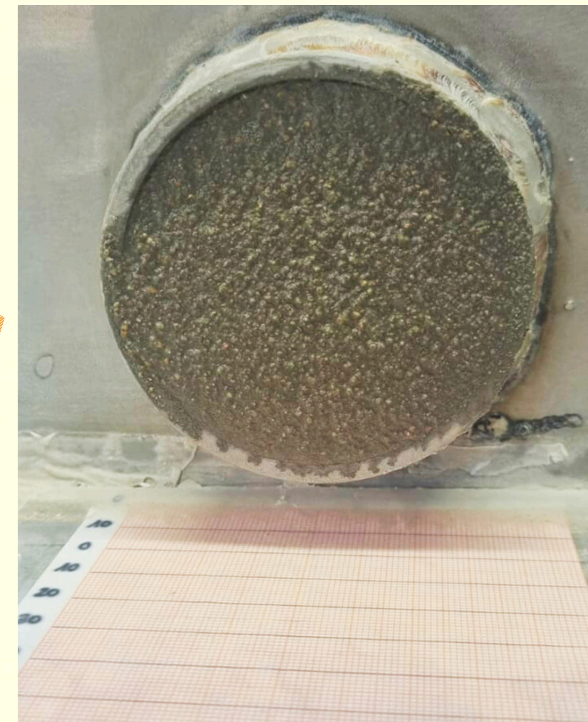
Fig.2 Intonaco con PENTAMIX ADX 115
