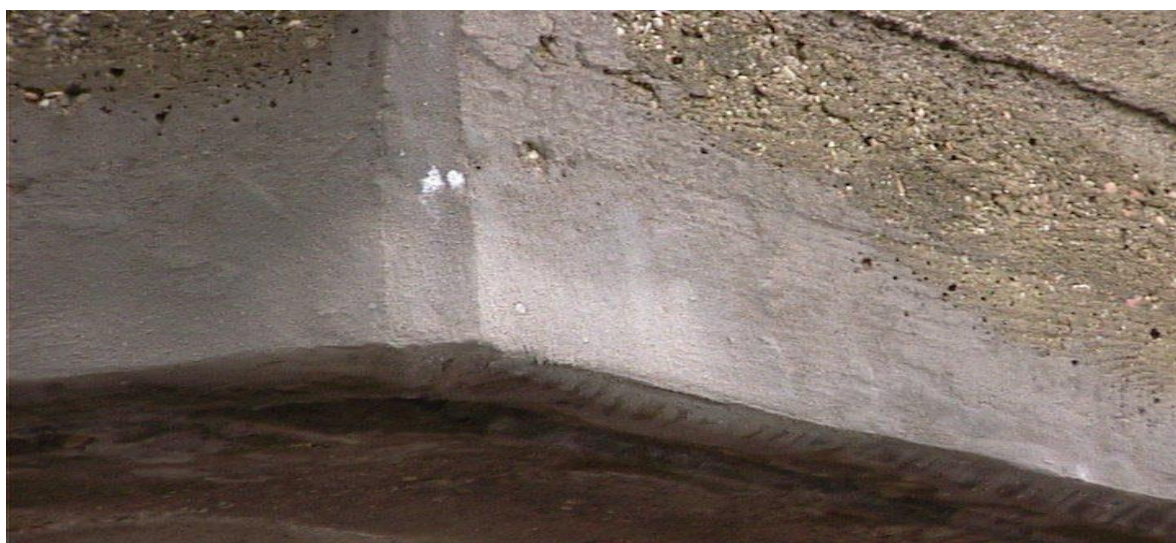
Aspect final d'un mortier de réparation formulée avec le Pentamix IT.1
