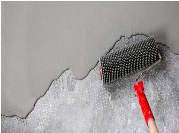
Photo d'une chape autonivelante réalisée avec le **Pentaflow AU.3**
